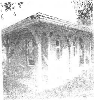
شكل (2) مبنى طيني جدرانه محمية بيروت السقف ومظلات خشبية في ألمانيا (Minke)
