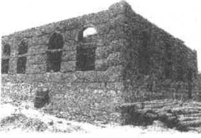
شكل رقم (17) مبنى قيد الإنشاء بتقنية الزابور في رحبان - صعدة (الباحث)
