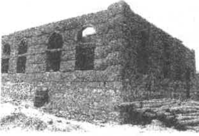
شكل رقم (17) مبنى قيد الإنشاء بتقنية الزابور في رحبان - صعدة (الباحث)
